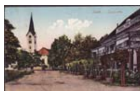
1638 Sisak, župna crkva, 1914. #/A-B 12
