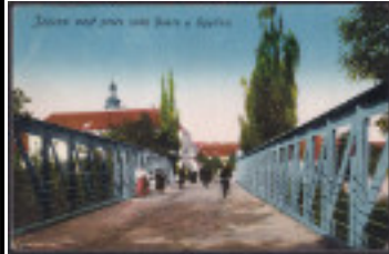
2072 Ogulin oko 12 1920. Željeznički most preko rijeke Dobre. #/ A-B
