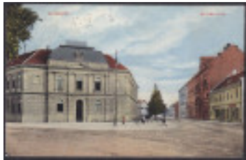
2067 Karlovac 1913. 16 Senjska ulica. #/ A-B
